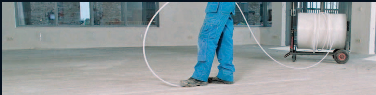
Einlaufen der Heizrohre in einem gefrästen Boden
